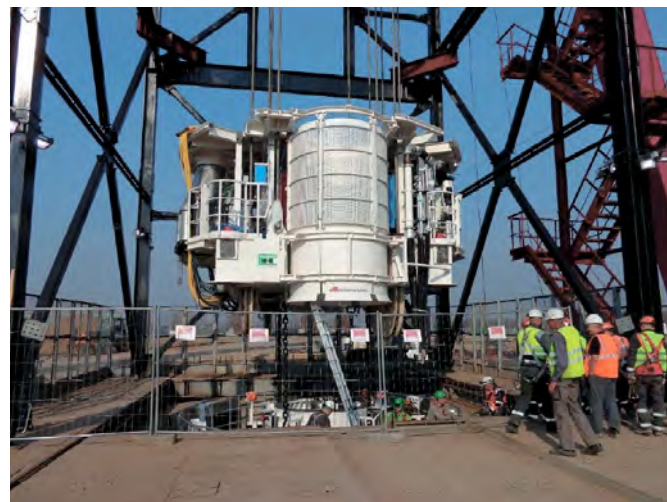
Рис. 7 Спуск модулей СБР в технологический отход
