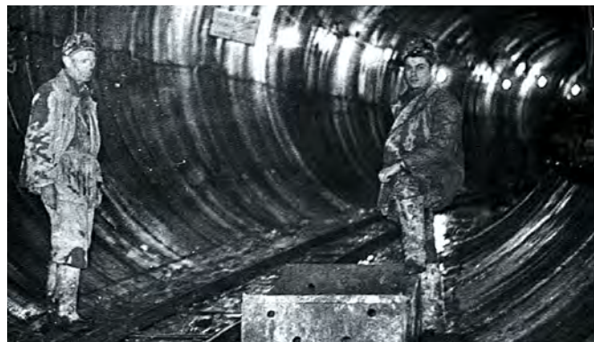
Б.А. Картозия на строительстве метрополитена
